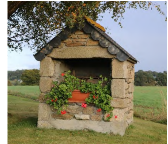
Puit au niveau de la ferme au Nord du hameau Le Cas des Pommiers
