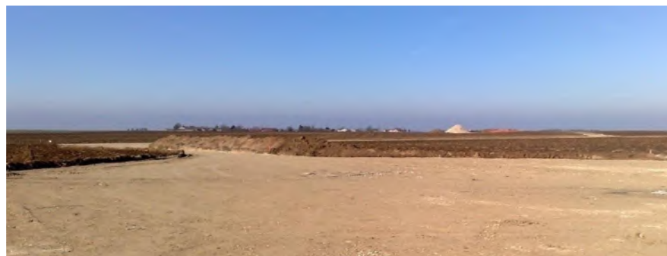
Figure 163 : Exemple d'aire de montage, grave compactée sur géotextile
